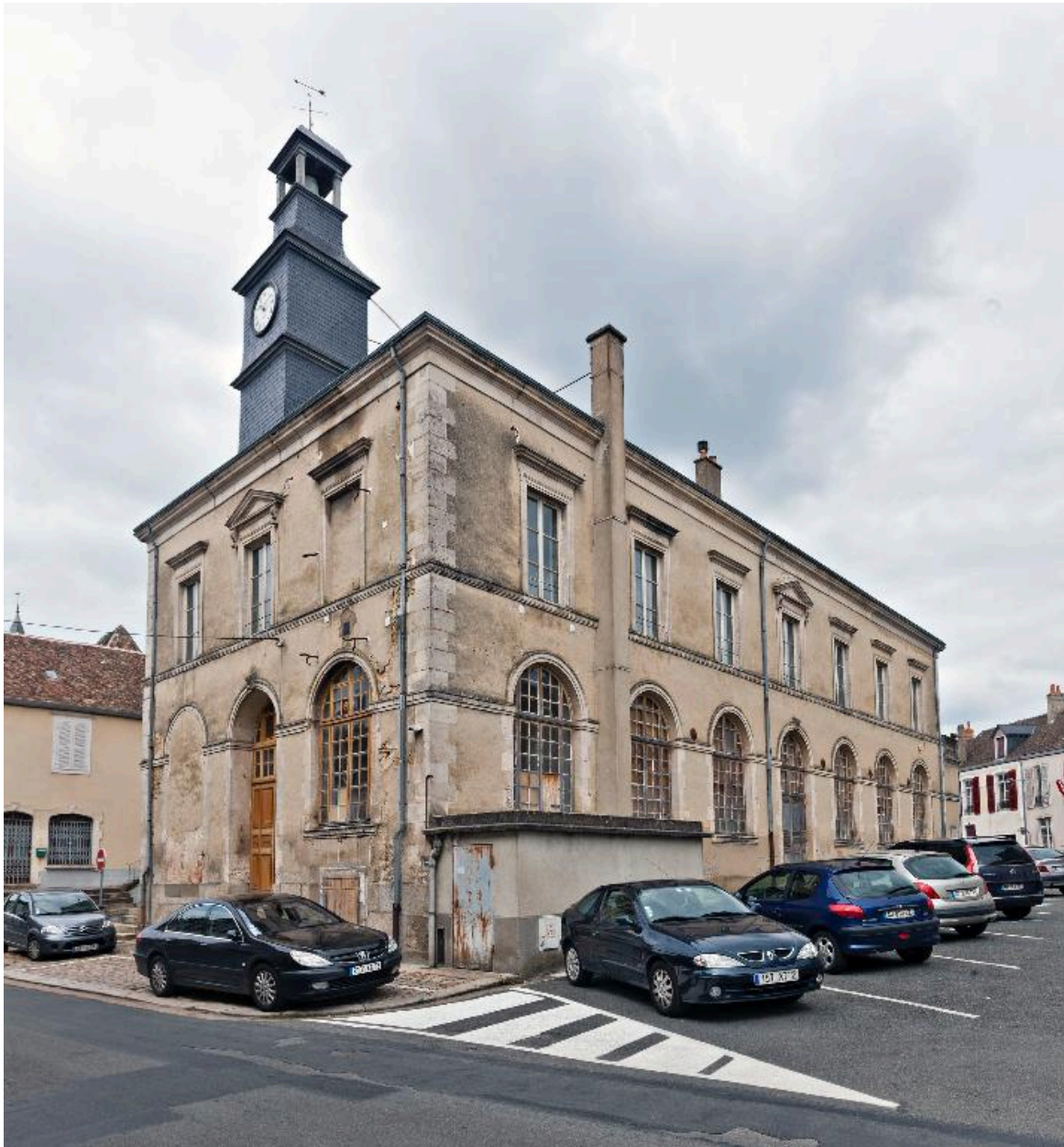
Vue depuis le sud.
