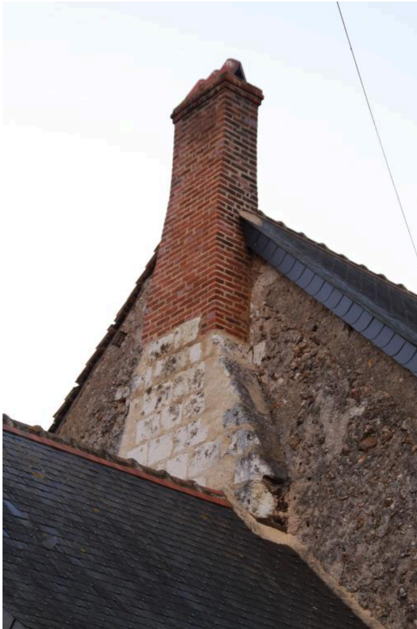
Logis, cheminée au pignon sud-est.
