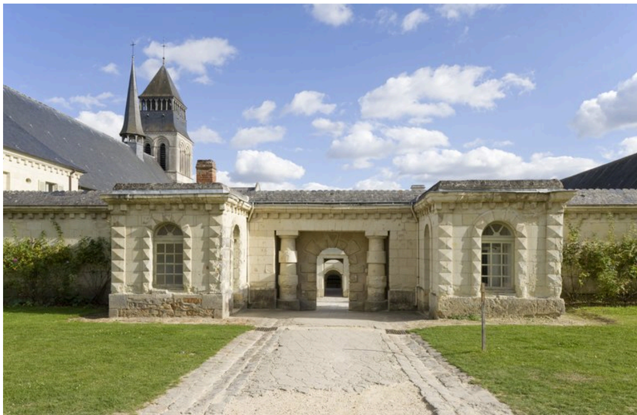
Prison, entrée de la 3e enceinte carcérale, encadrée de colonnes à bossages un-sur-deux (vers 1810) et de deux guichets (2e moitié du XIXe siècle).
