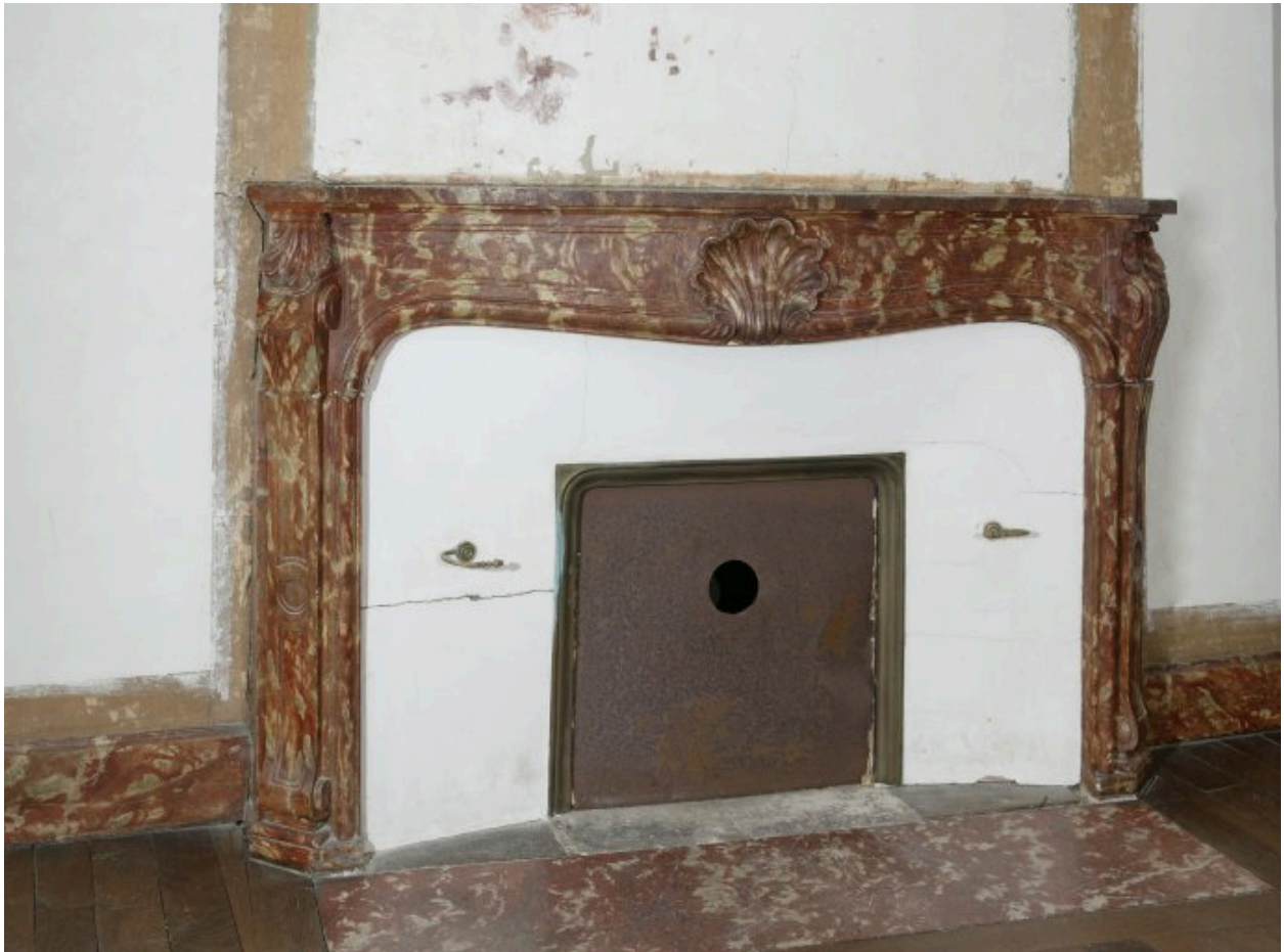
Cheminée en pierre, peinte faux-marbre, dans l'une des chambres du n° 2.
