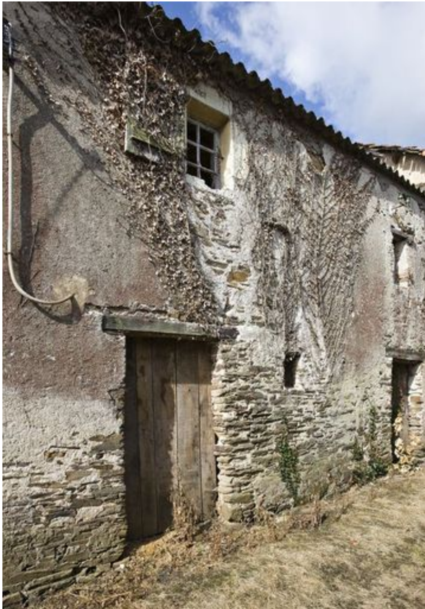
Rue Saint-Vincent, venelle latérale : maison 17e-18e siècles.
