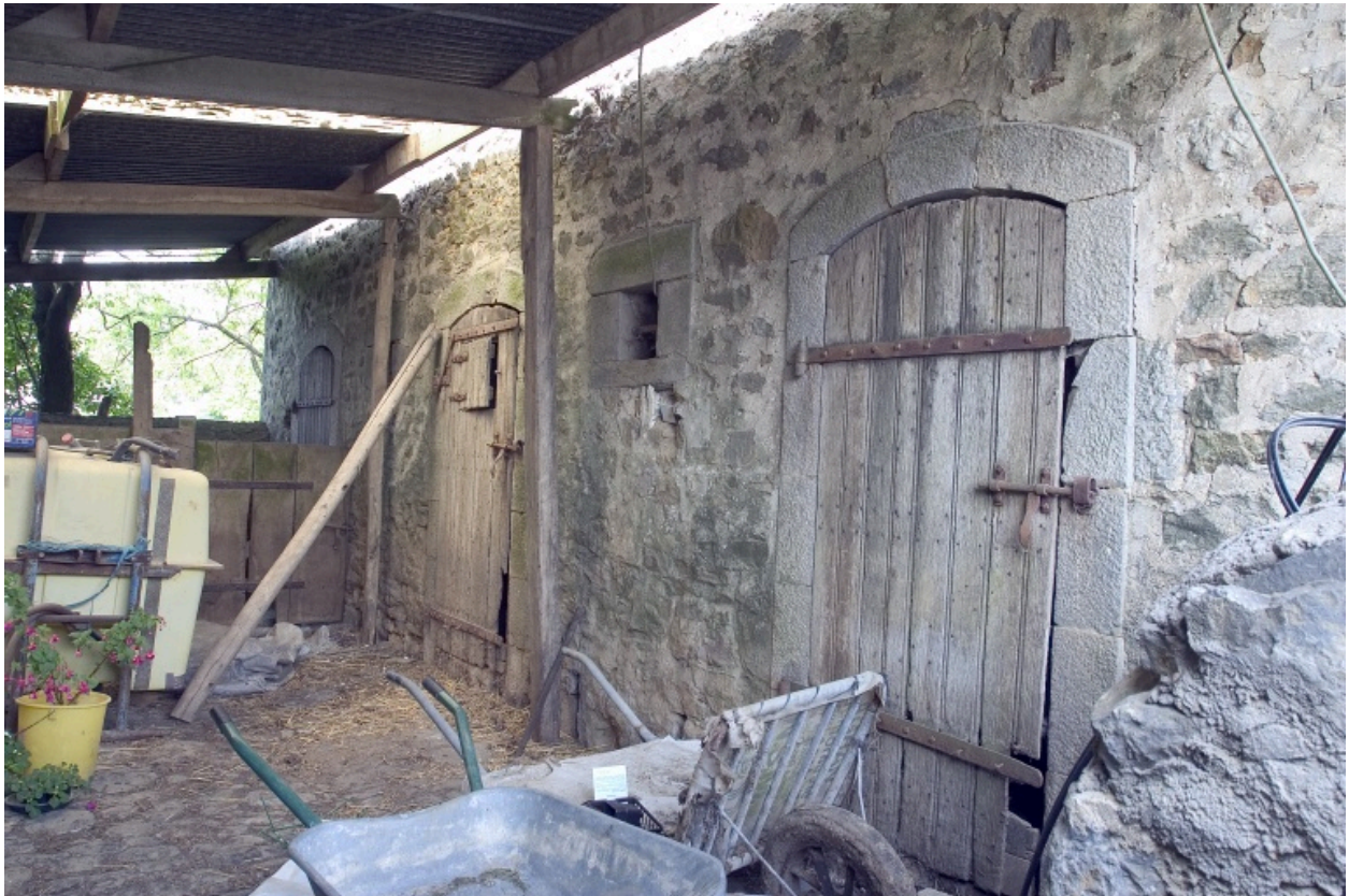
L'élévation sud de la porcherie : les portes des soues.
