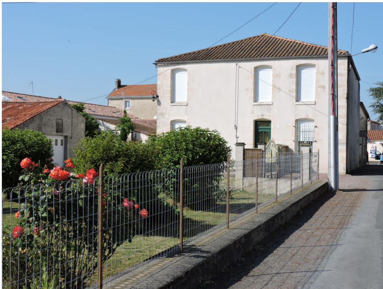
La demeure construite en 1768, au 2 rue de la Liberté, vue depuis le nord.
