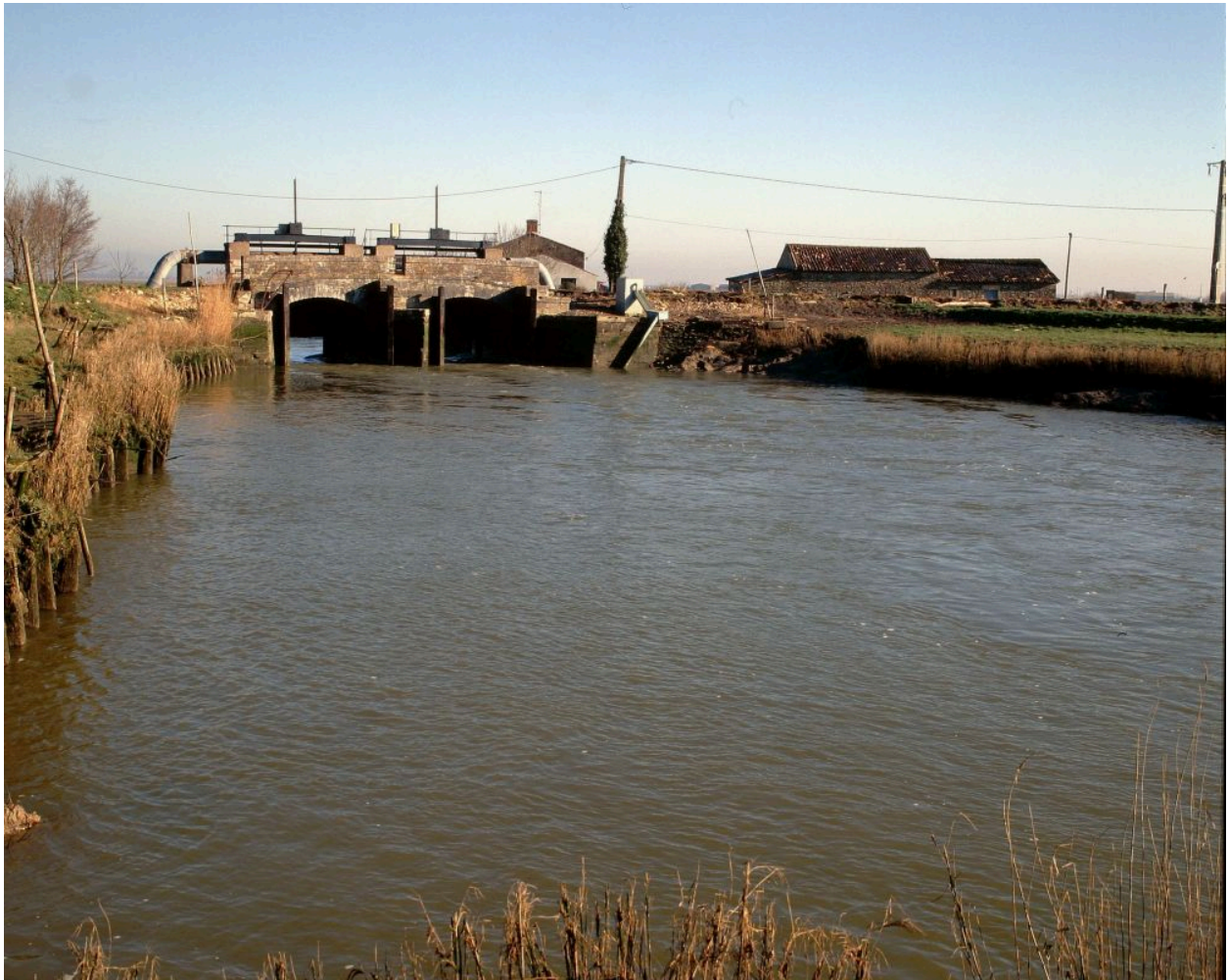
Les portes vues depuis l'aval.
