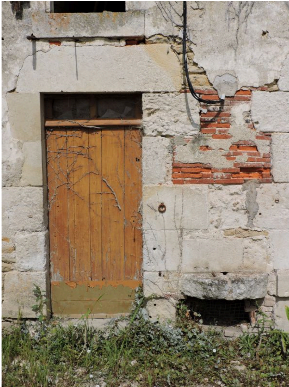
La porte et la pierre d'évier de l'ancien logement.
