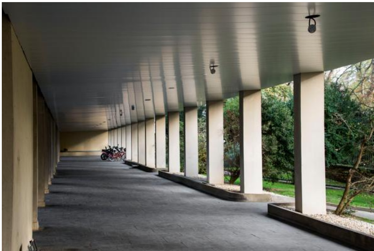
Vue du dégagement en rez-de-chaussée côté parc.
