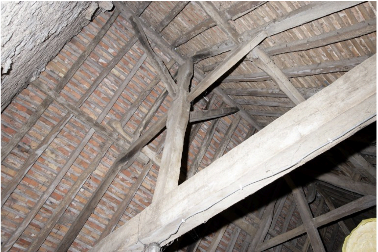
Partie centrale des anciens logis contigus : ferme de chapente nord.
