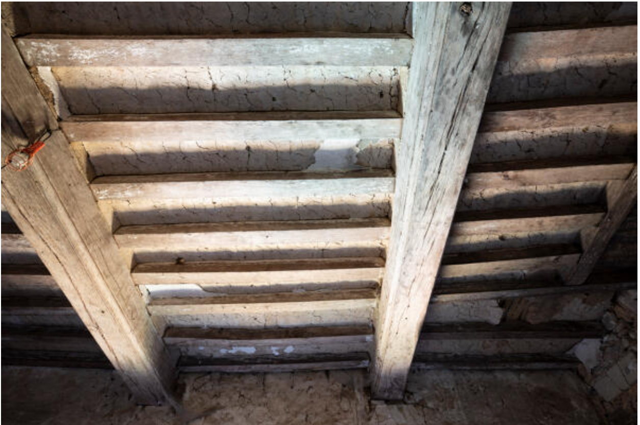
Le plafond d'une ancienne chambre.
