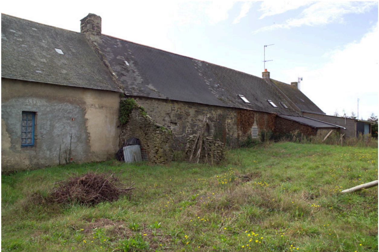
Élévation postérieure, partie ouest.
