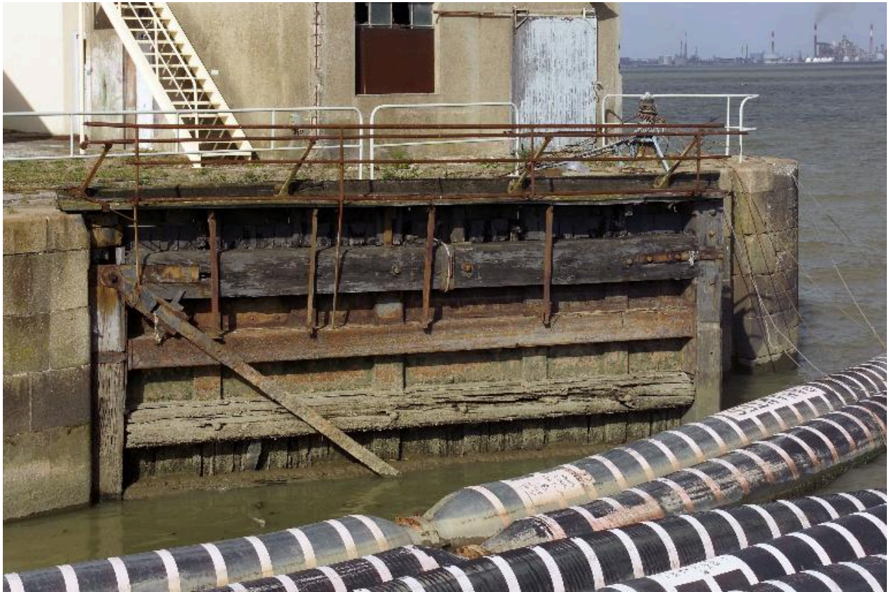
Le bassin de carénage, détail de la porte éclusière.
