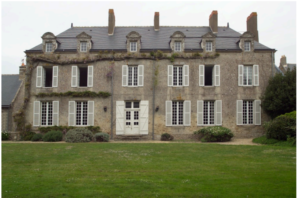
Hôtel XVIIIe siècle, vue de la façade postérieure.
