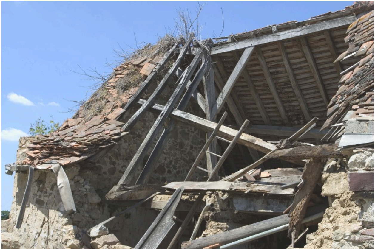
La charpente de l'ancien logis ouest.
