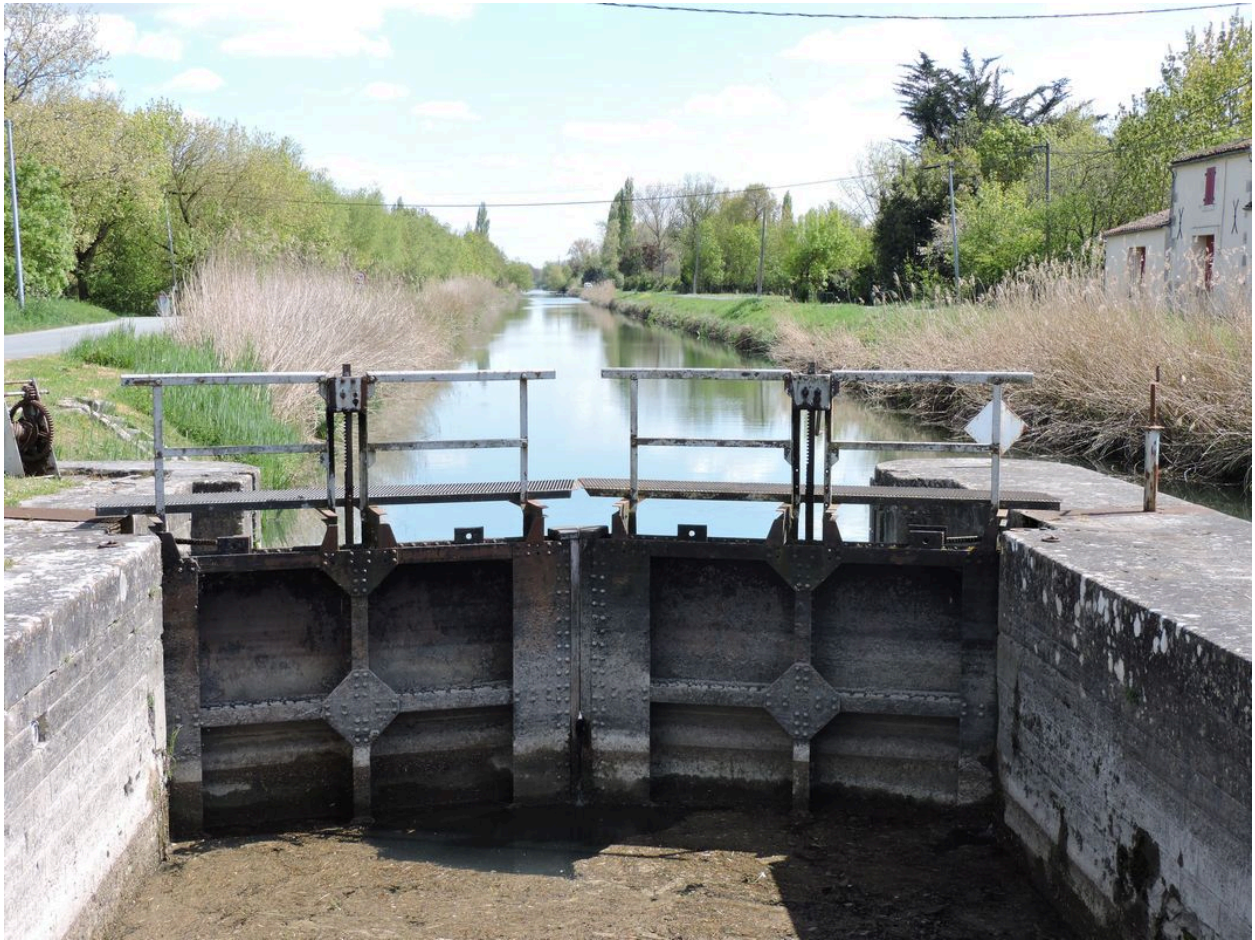
La porte amont de l'écluse.
