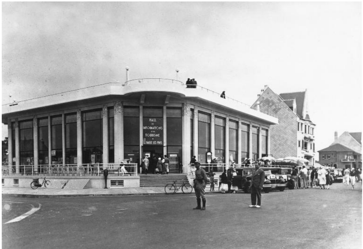
Façades sud et ouest du hall des informations et du tourisme de La Baule-les-Pins.
