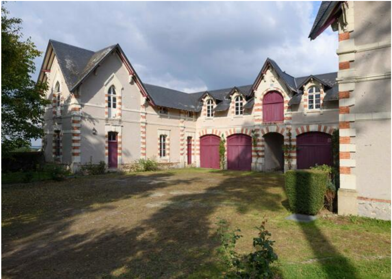
Vue de l'aile nord-ouest et du corps principal depuis l'ouest.
