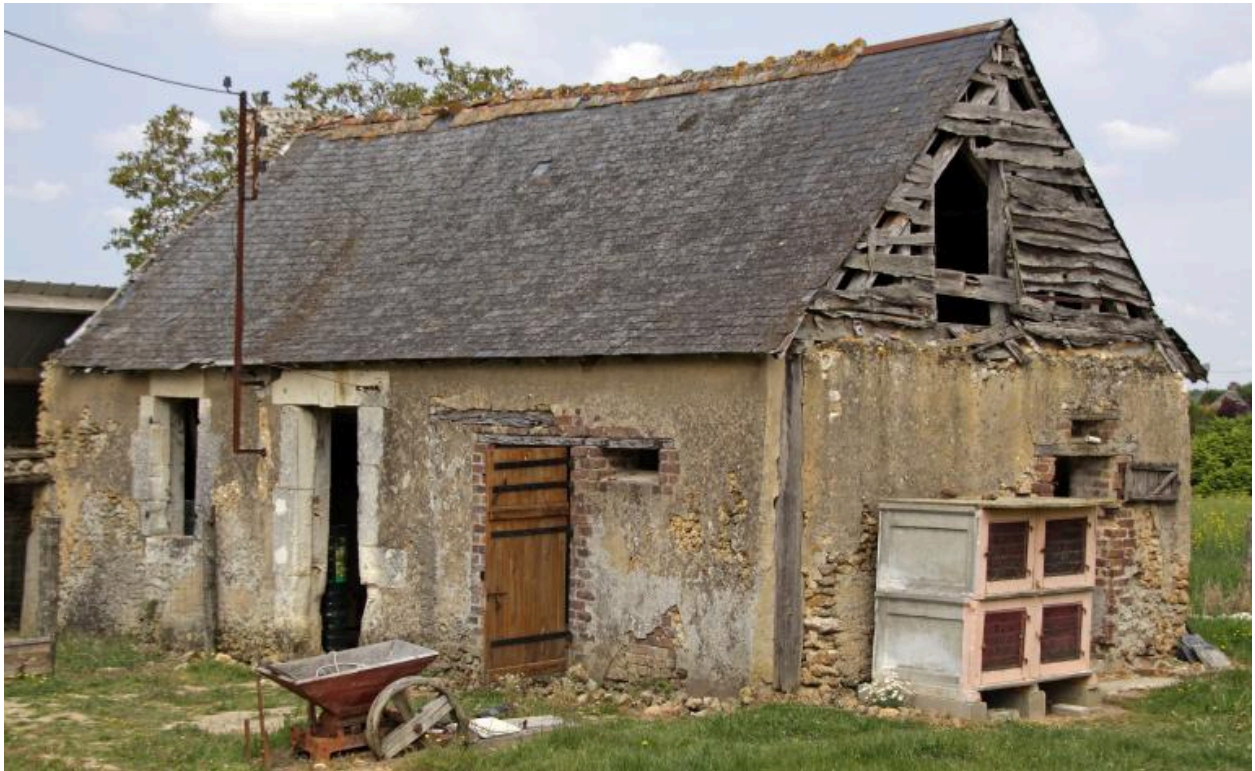
Vue de volume de la maison 1, avec mur-pignon est.
