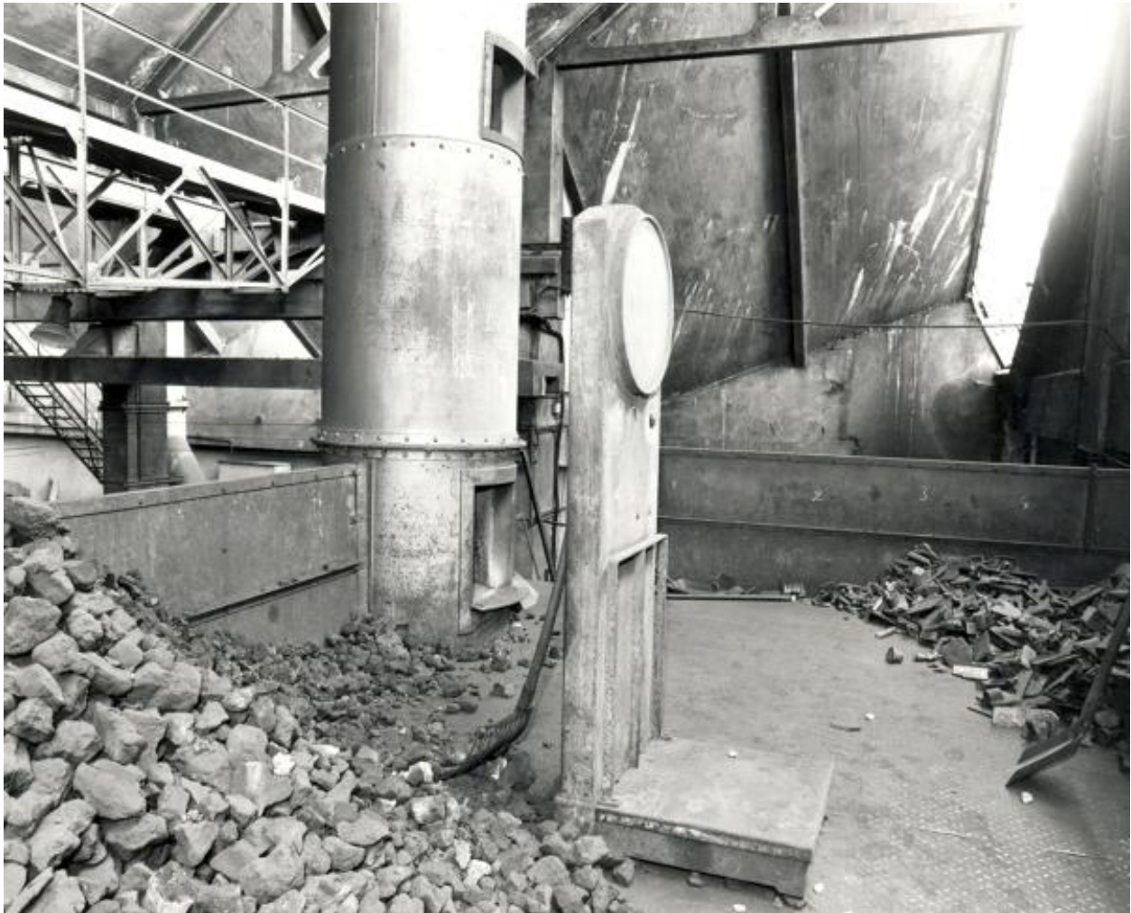
Atelier de fonderie : cubilot gauche, passerelle supérieure avec les stocks de coke et de ferraille à enfourner.
