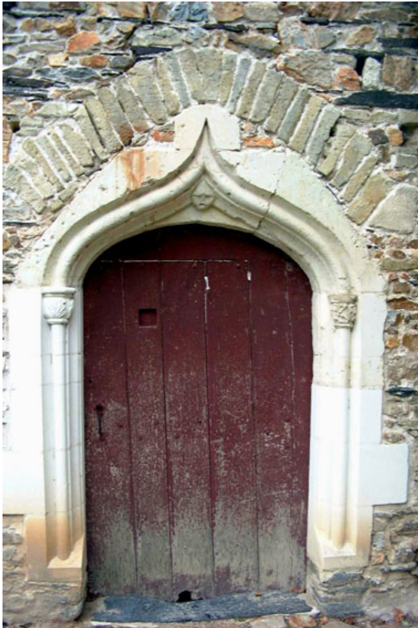
Porte en tuffeau de la tourelle d'escalier (2e moitié du 15e siècle).
