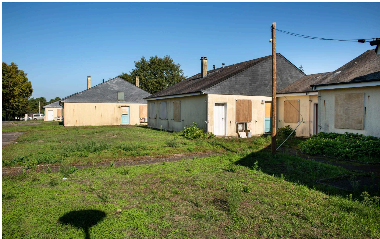
Vue des maisons sud, avenue des Platanes.
