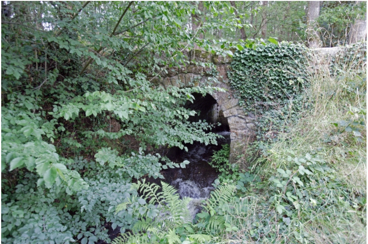
Le pont sur le ruisseau de Lassay, vu depuis le nord.
