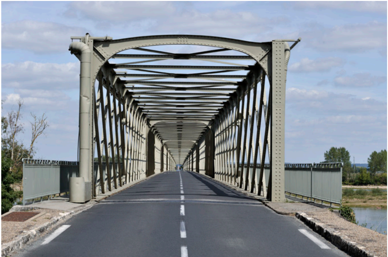
Entrée du pont depuis la rive sud de la Loire
