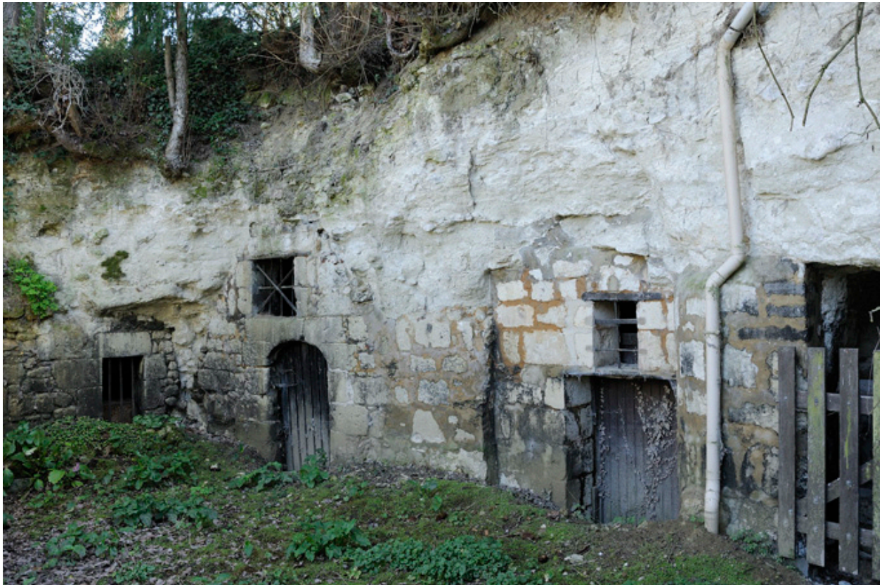
Détail des maçonneries qui ferment les abris
