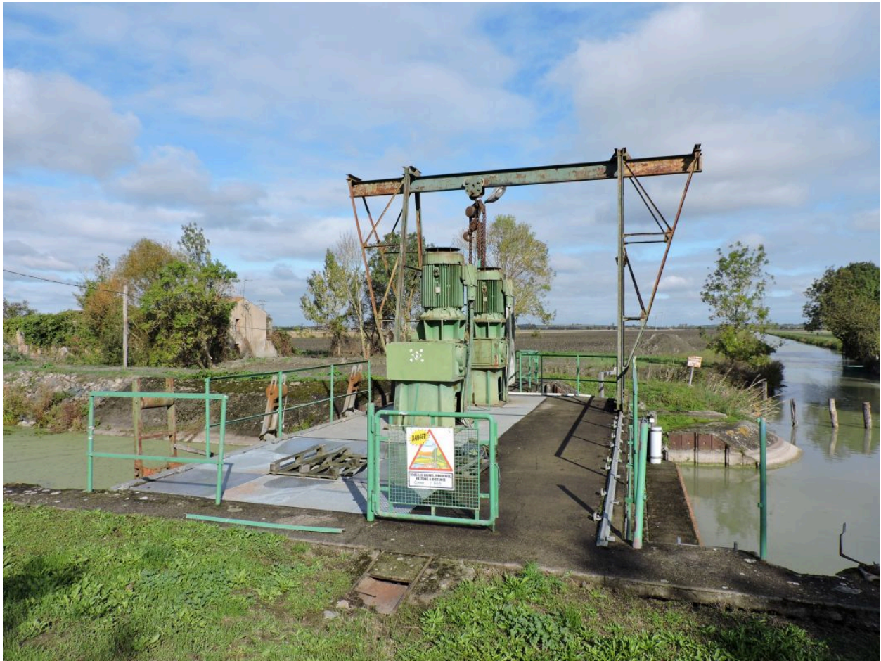
Le barrage vu depuis la rive gauche du canal de Vix, au sud.
