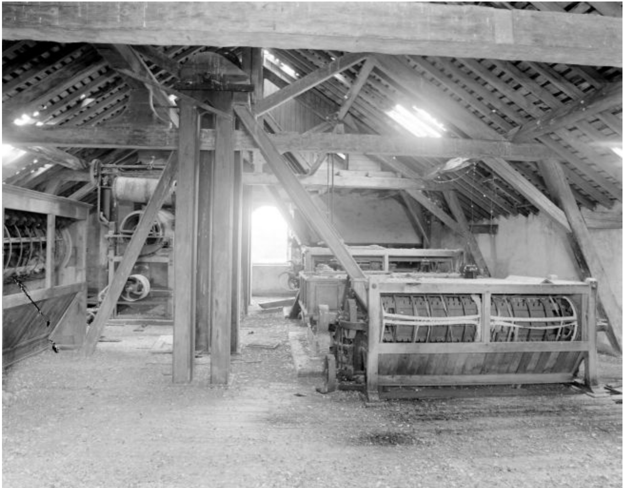
Comble en 2002. Vue depuis le nord-ouest.
