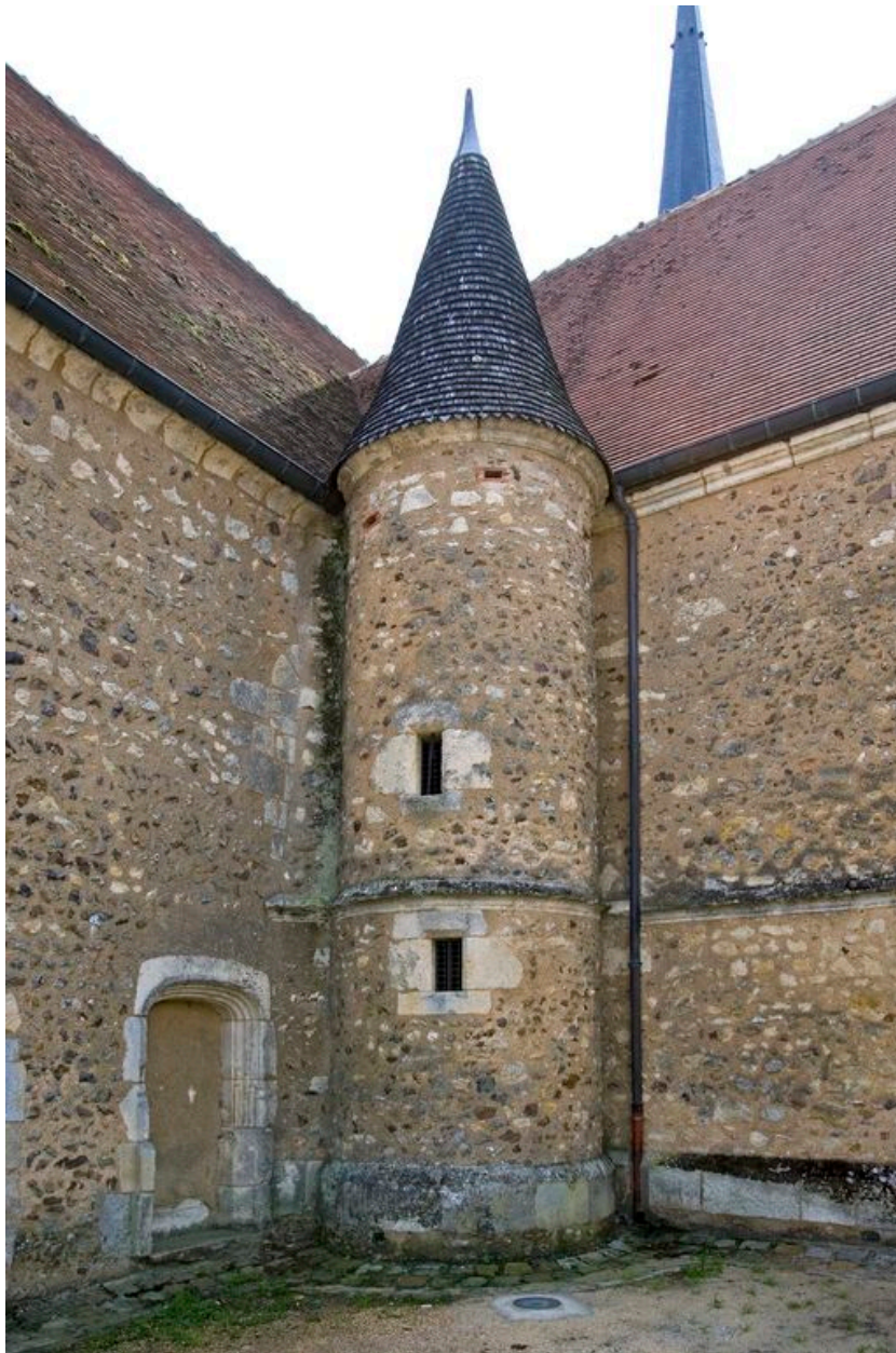
Tour d'escalier dans l'angle du bas-côté nord et du chœur
