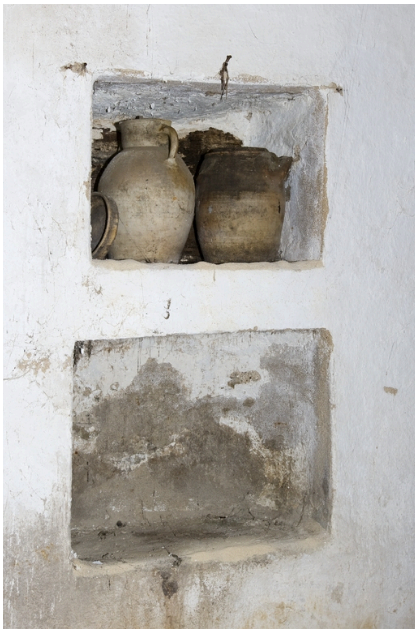
15 rue Jeanne-de-Navarre. Rez-de-chaussée. Détail du placard mural.
