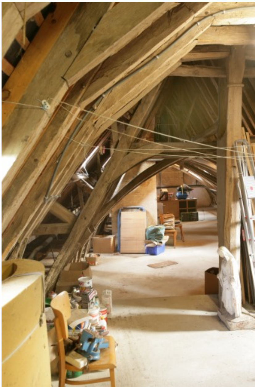
La charpente : la jonction entre les deux parties vue depuis l'ouest.
