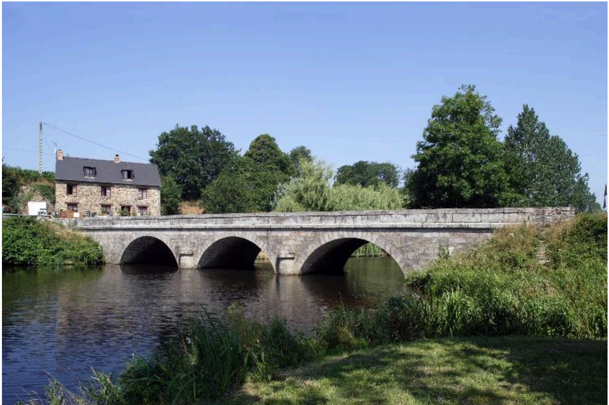
Le pont Landry vu depuis l'aval au sud.
