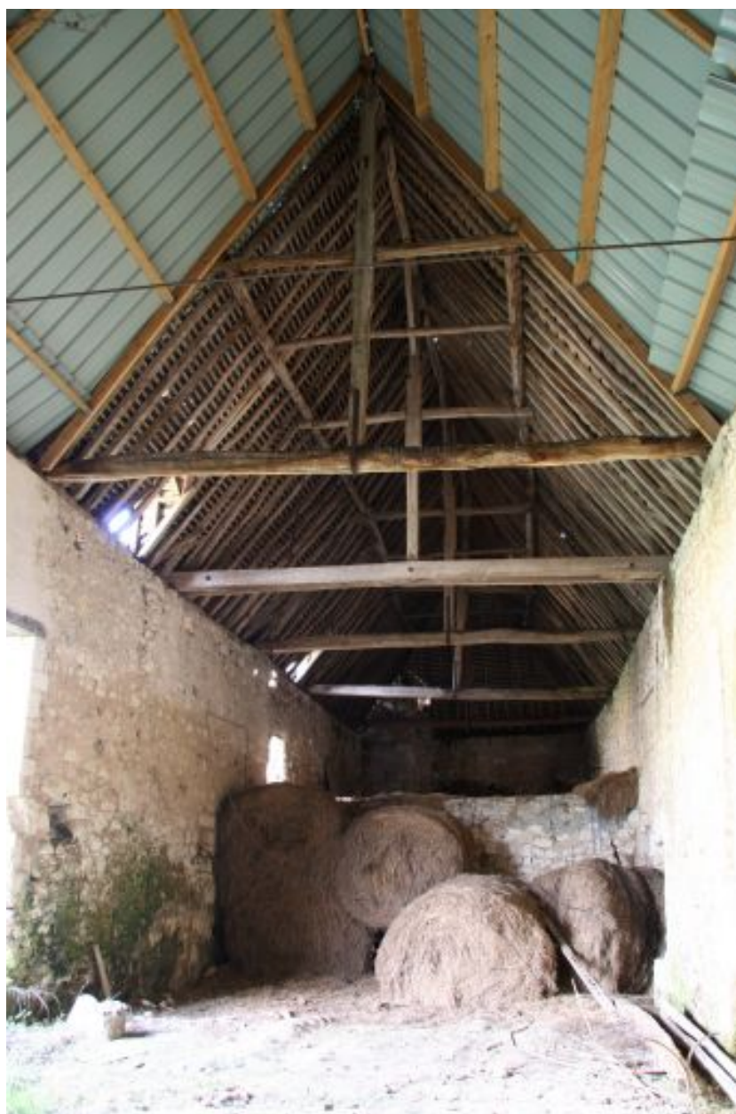
Les communs : vue prise vers le pavillon nord-est.
