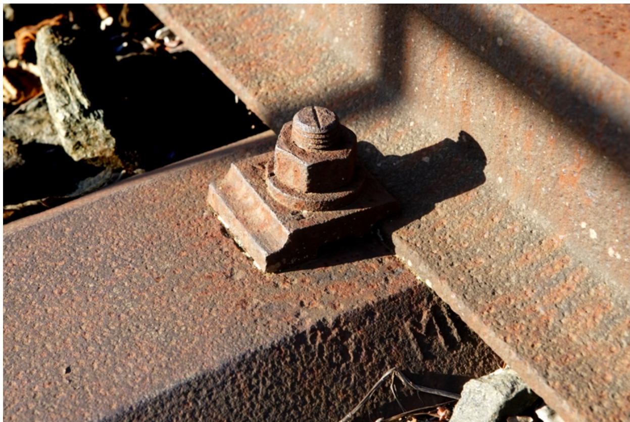
Fixation sur traverse métallique avec un crapaud.
