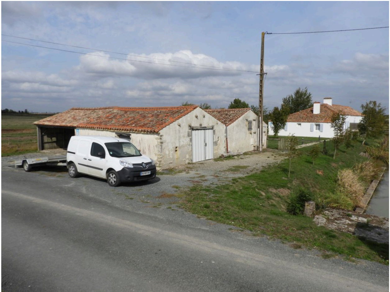
L'ancienne maison de garde, au second plan, et ses dépendances, vues depuis le sud.
