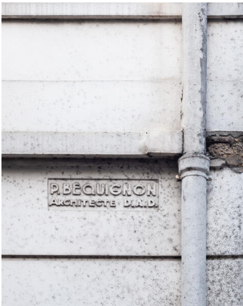
Détail de la plaque d'architecte.
