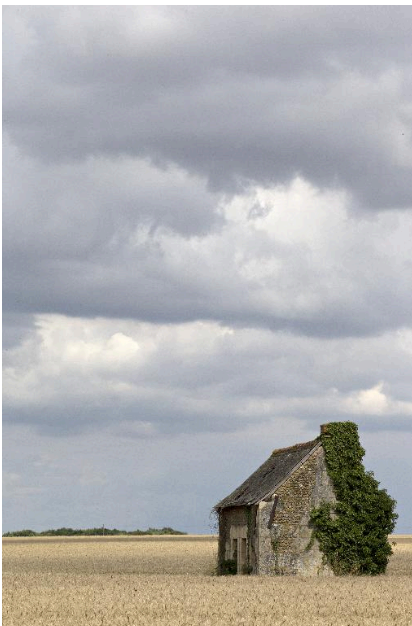
Poncé-sur-le-Loir. Maison de vigne : vue de volume avec façade principale.
