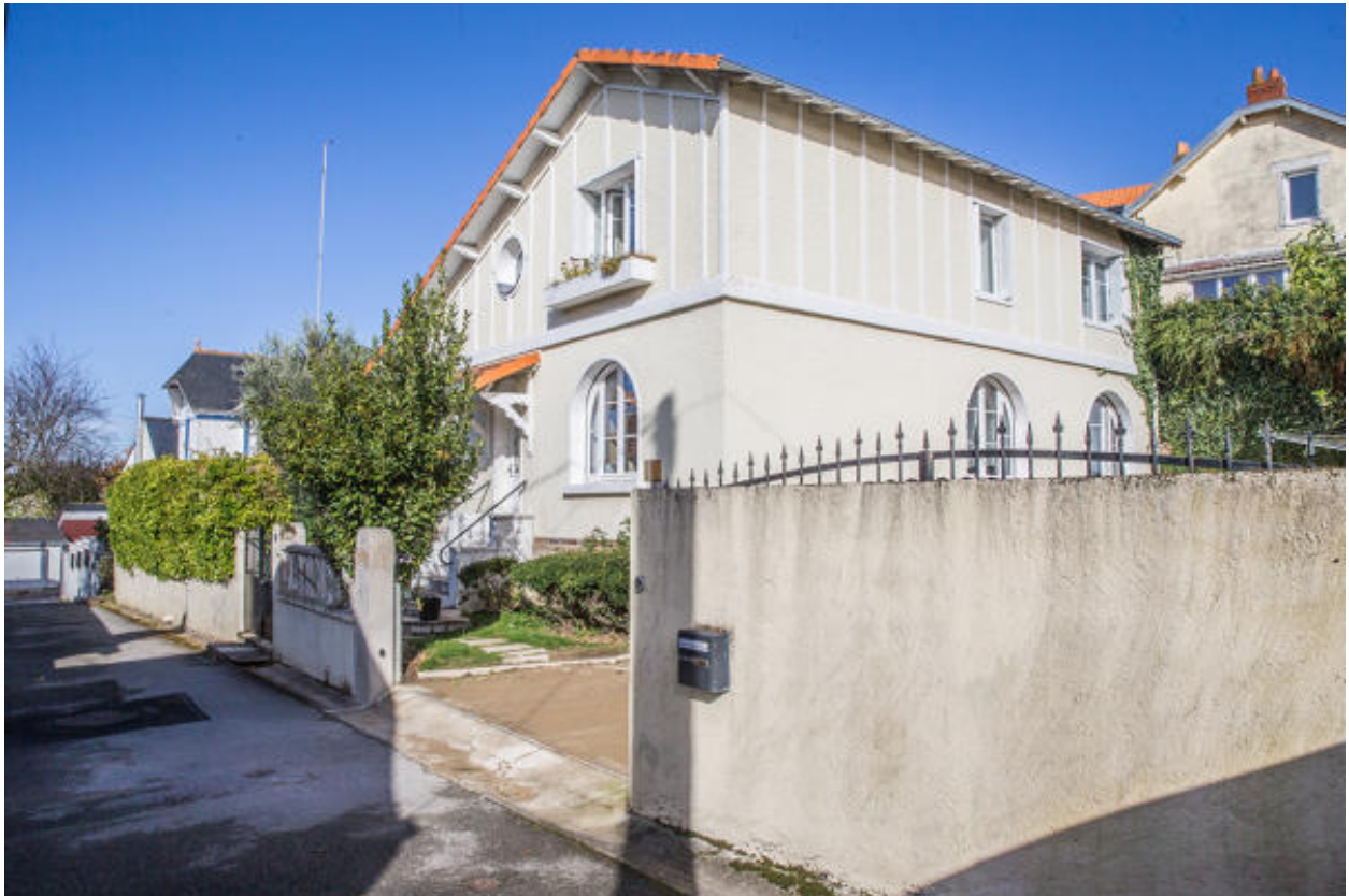
Maison, 2 rue du Bocage.
