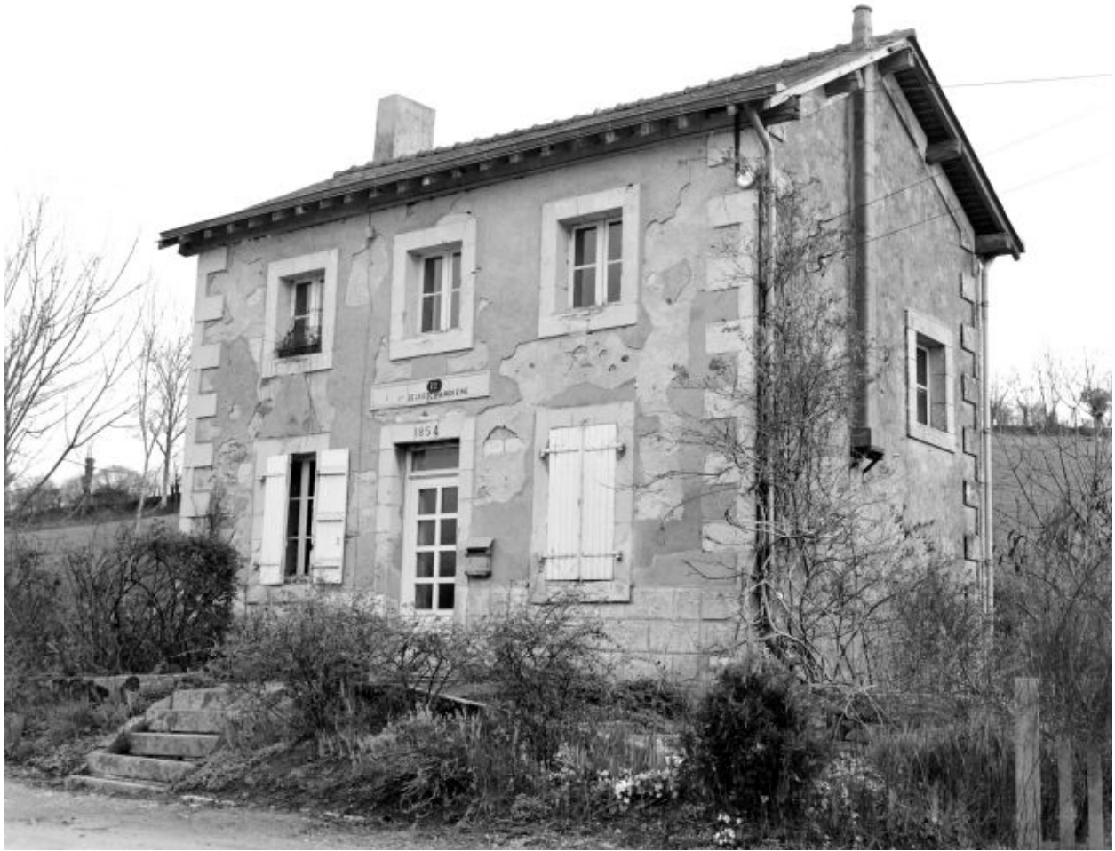
La maison éclusière.
