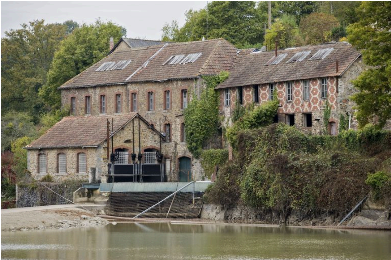
Les deux corps principaux de l'usine et le bâtiment des turbines, vus depuis l'amont, pendant les écourues de 2009.
