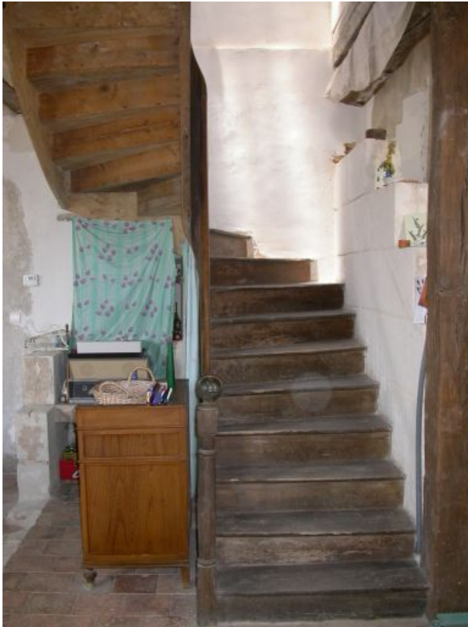
Maison 5 : escalier tournant dans oeuvre jadis fermé.
