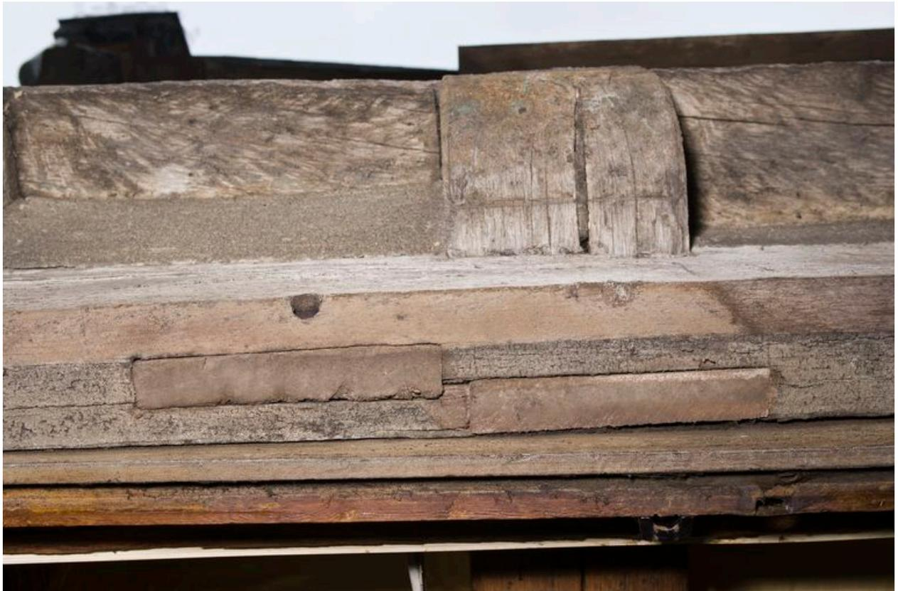
1er étage, fenêtre sur la rue Beaurepaire, sablière de plancher du 2e étage : mortaises bouchées correspondant au poteau d'hubriserie gauche de la fenêtre d'origine et à une des décharges d'une croix de St-André disparue.
