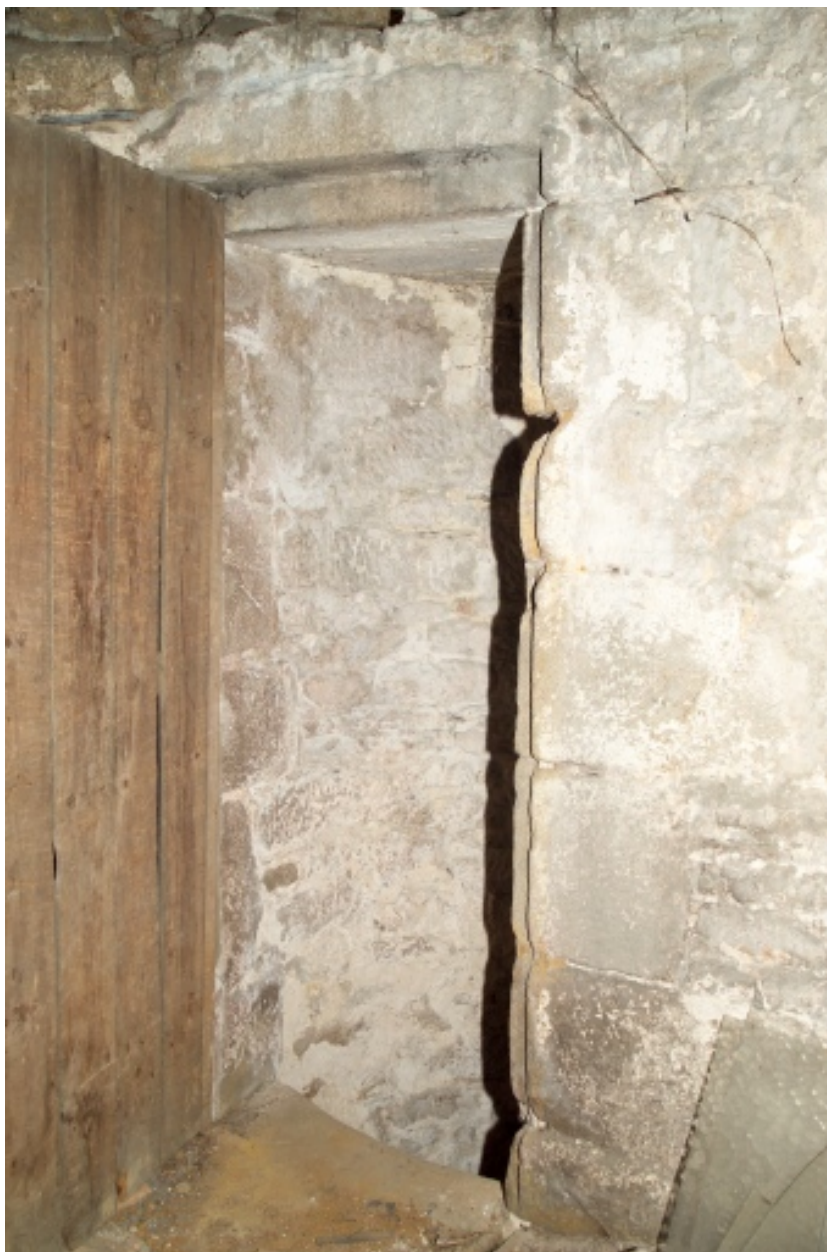
Salle au sommet de la tour d'escalier, porte (parement interne).
