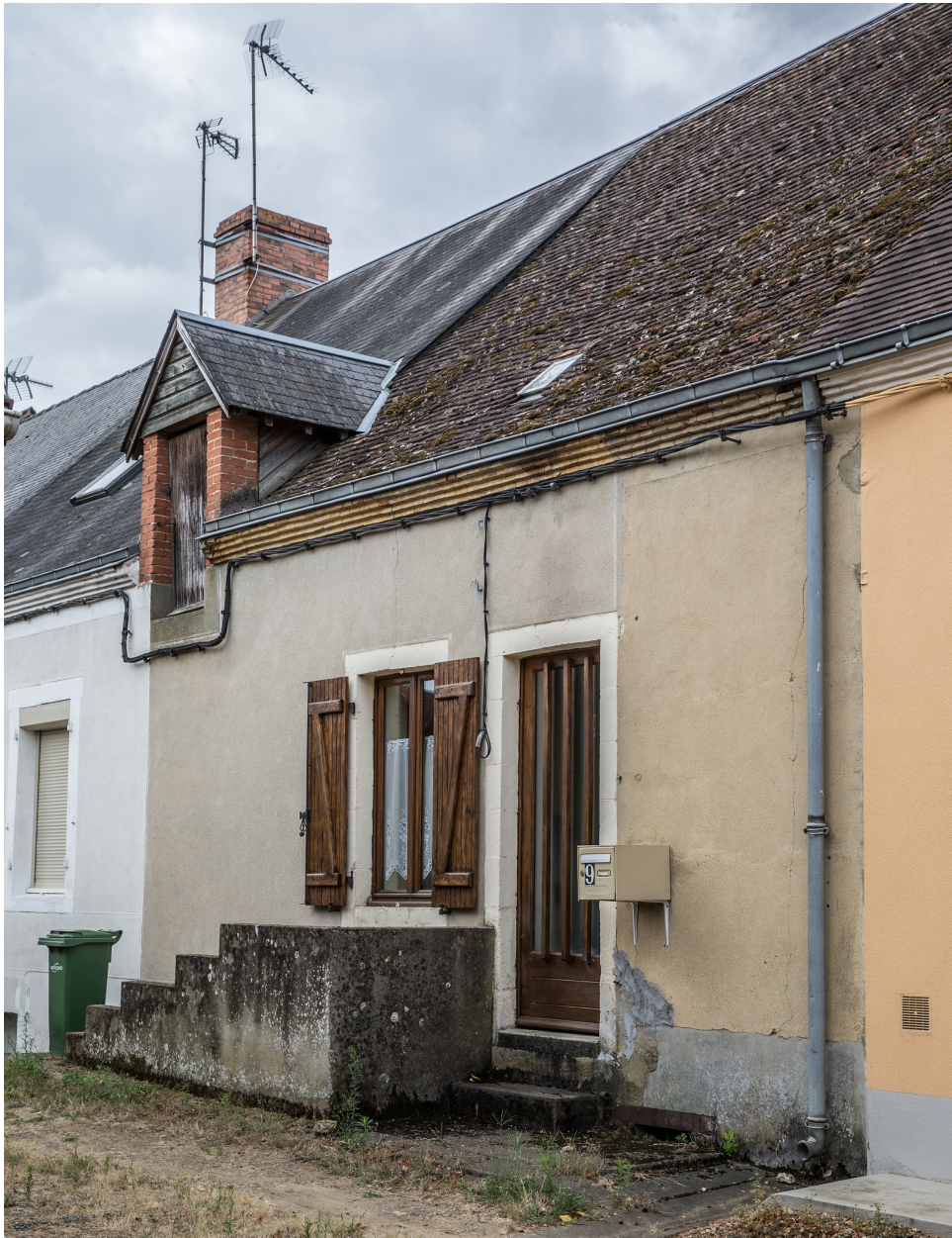
Une maison de tisserand, rue de Belfort.
