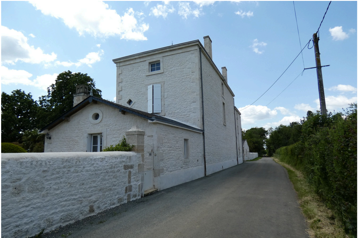
Le logis vu depuis le nord-est.
