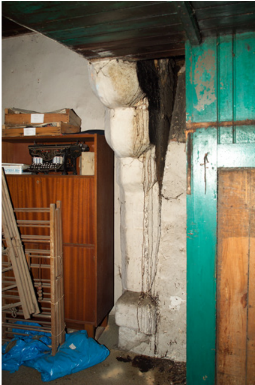
Corps principal, premier étage, pièce orientale, cheminée, détail du montant gauche.
