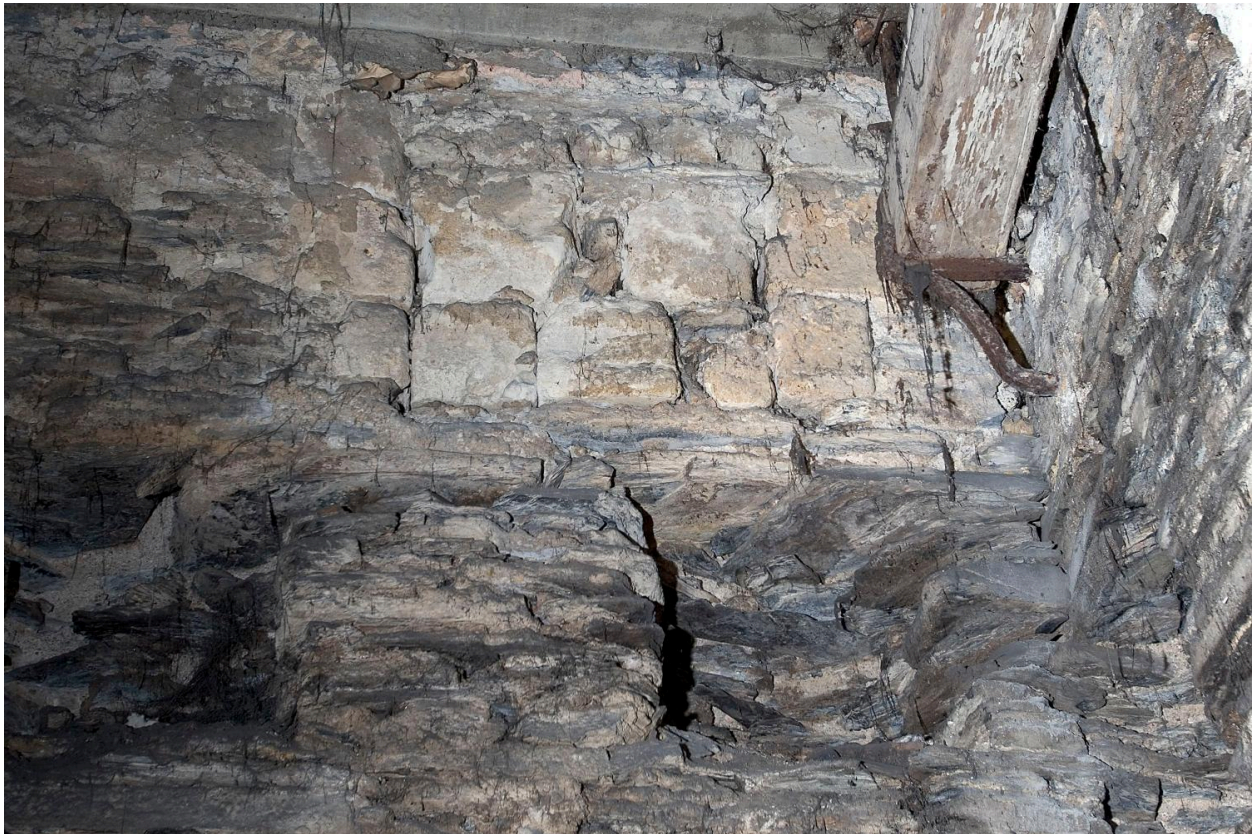
Corps de bâtiment du petit séminaire, sous-sol : cave 7, face postérieure, angle postérieur droit, détail sur une ouverture murée.
