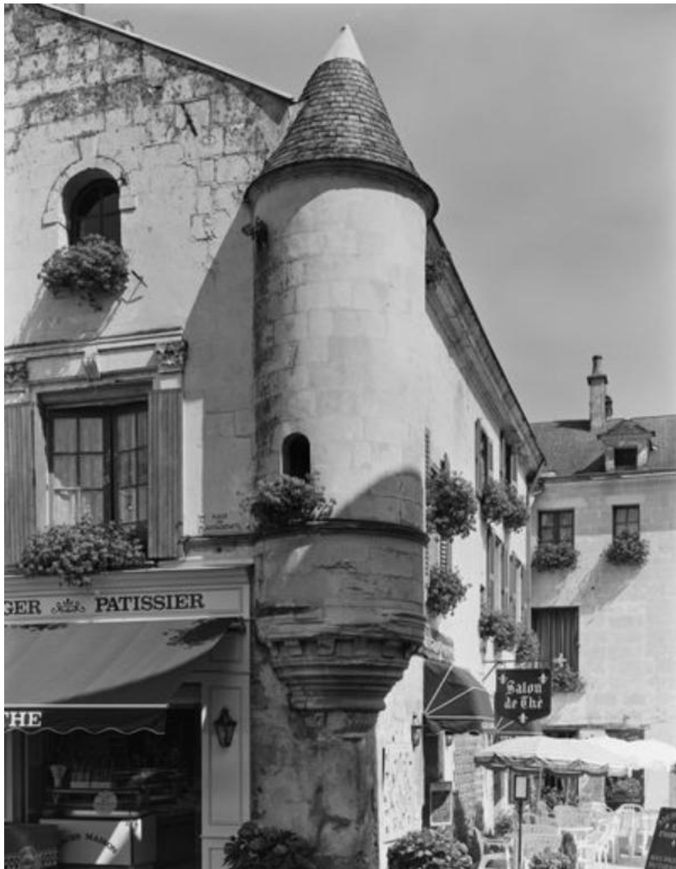
Détail de la tourelle, avant restauration (en 1994).
