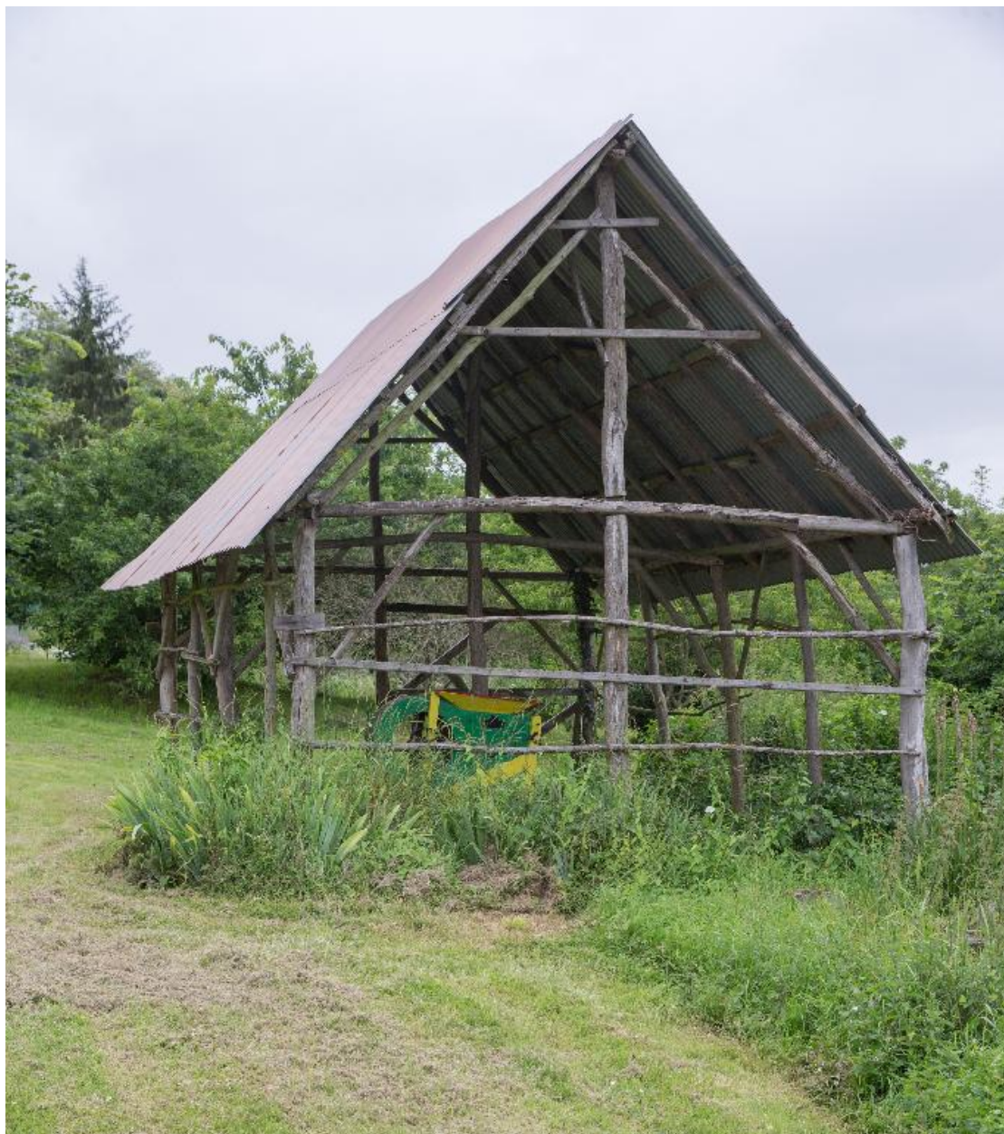
Hangar à structure en bois.
