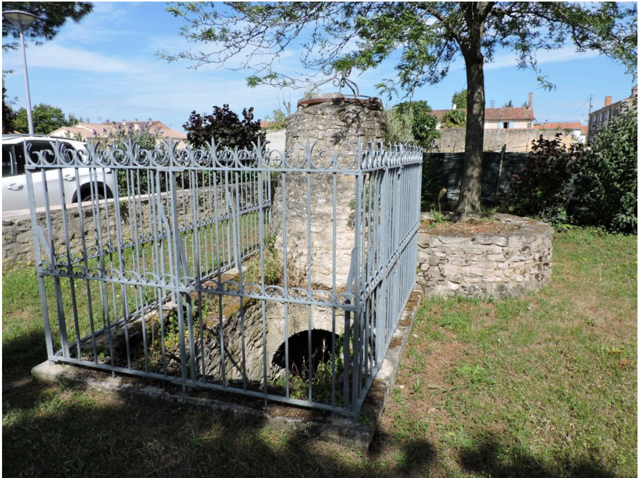
Le puits vu depuis l'est.
